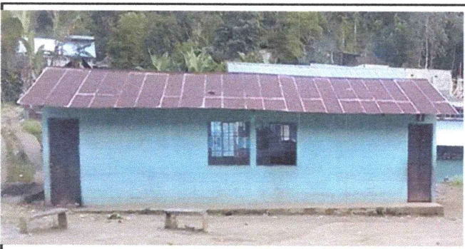
Foto 5: Sustitucion de laminas por laminas troquelada aluzinc calibre 26
