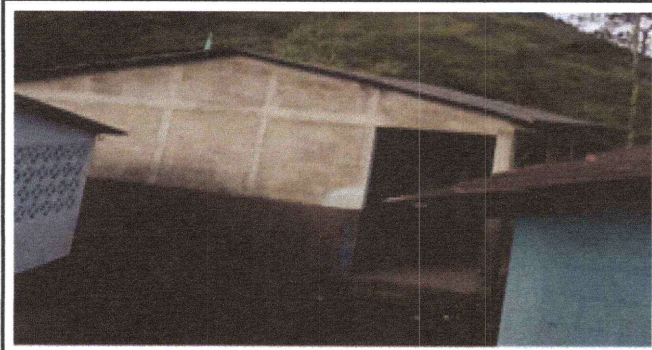
Foto 3: Sustitucion de lamina por lamina troquelada aluzinc calibre 26
