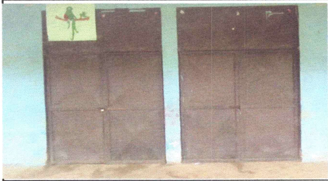
Foto 1: Mantenimiento de estructura de puerta lijado cepillado aplicacion de pintura modulo 1
