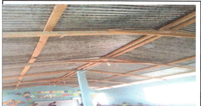
Foto 4: Sustitucion de estructura de soporte de maderapor metal modulo 3
