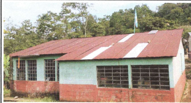
Foto1: Sustitucion de láminas por lámina troquelada aluzinc calibre 26 modulo 1
