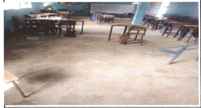
Foto 2: Mantenimiento de piso de granito (pullido y lustrado modulo 3
