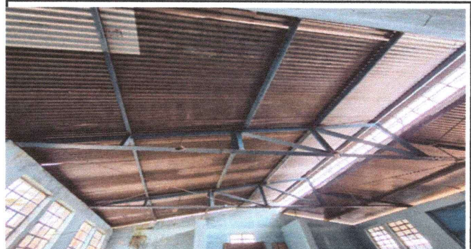
Foto 2: Mantenimiento de estructura de soporte de metal aplicación de pintura modulo 1
